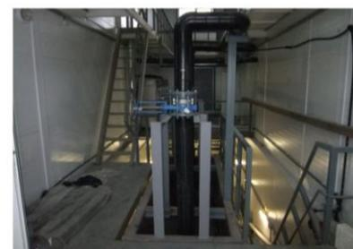
Камера смешения с циркуляционными насосами
